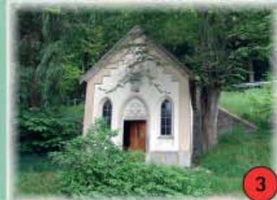
3 Zwieselbergkapelle Böhmzwiesel Die Renovierung der 1838 erbauten und der heiligen Maria geweihten Kapelle erfolgte im Jahr 1983.
